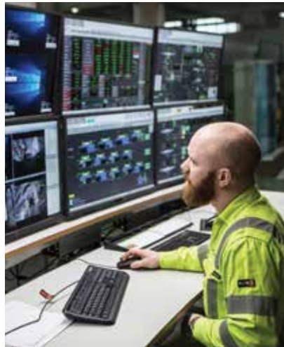
Zinkgruvan – New Control Room
