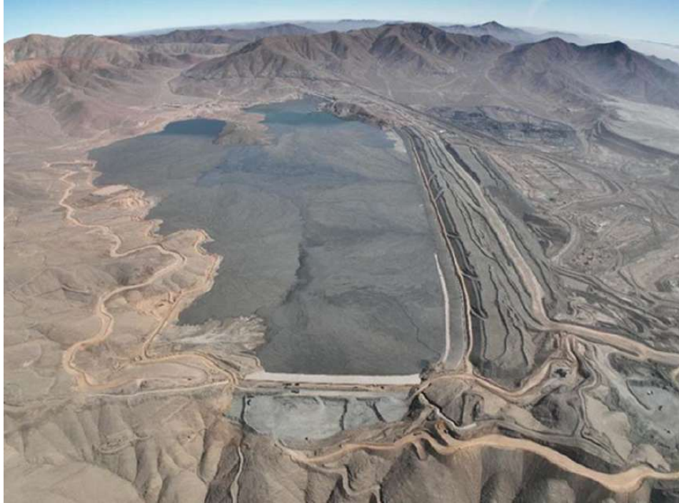
Figure 1: Los Diques Tailings Storage Facility Actual Layout
